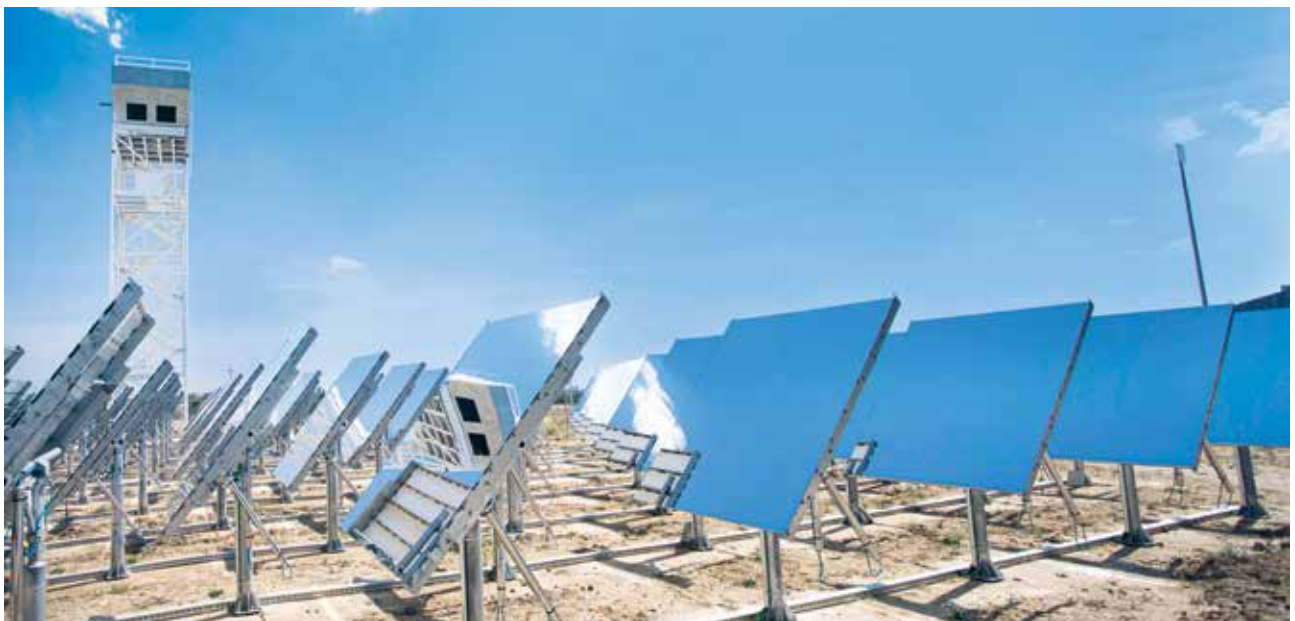
Sun-to-liquid-Verfahren (StL) — Eine Sun-to-liquid-Anlage produziert Kerosin aus Sonnenlicht, Wasser und CO 2 . Das funktioniert schon heute in der Praxis: In Madrid wurde am IMDEA Energy Institute eine einzigartige Solaranlage errichtet und über vier Jahre ausgiebig getestet. Die MTU war mit an Bord - über ihre Beteiligung am Bauhaus Luftfahrt. Der Think Tank der deutschen Luftfahrt verantwortete die gesamte Technologie- und Systemanalyse. Nun geht es darum, das Produktionsverfahren zu skalieren.
